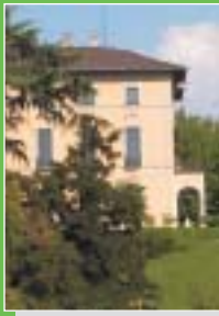
Varese: Villa Montalbano Esengrini
