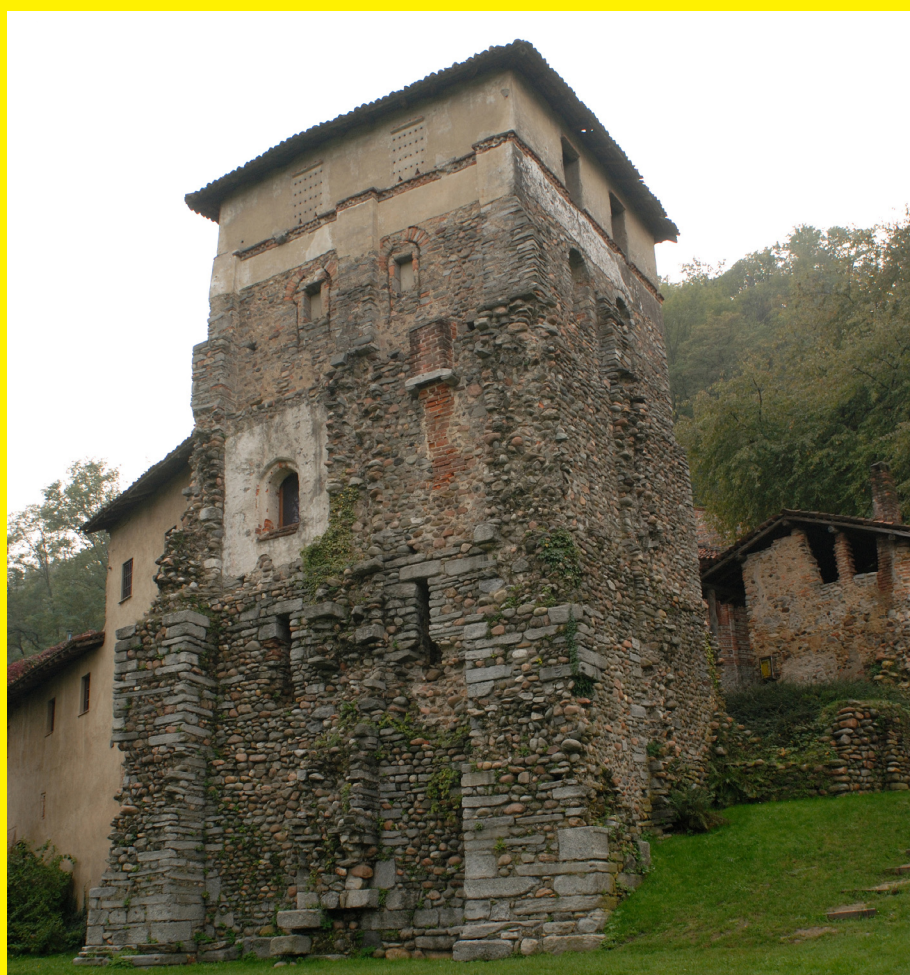
Torba. La torre da Nord-Est
